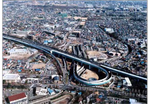
写真-1 大泉 JCT 航空写真
