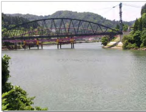
写真-2 只見線落橋(仮バント支保)
