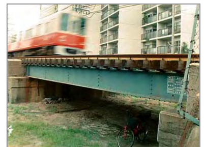
写真-4 避溢橋例
