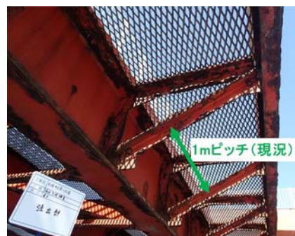
写真-1 現況床材及び横桁・ブラケット
