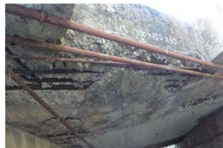
写真-1 既設床版下面状況
