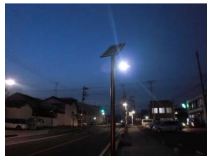
写真-1 設置状況
