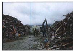
(東日本大震災における道路の啓開状況)
