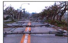
(台風による道路の被災状況)
